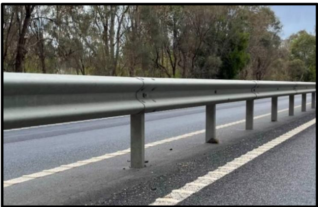
ตัวอย่างเกาะกลางถนนแบบราวกันชนเหล็ก ชนิดติดตั้งบนผิวคอนกรีต (Surface-Mounted Guardrail)
