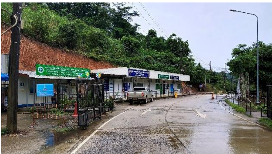
บริเวณอาคารสำนักงานด้านฯ กม.1+800 ขวาทาง
