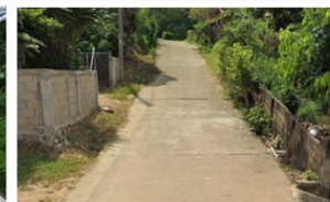
3 ถ.ท้องถื่น (ซอย 1)
