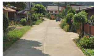
5 ถ.ท้องถื่น (ซอย 3)
