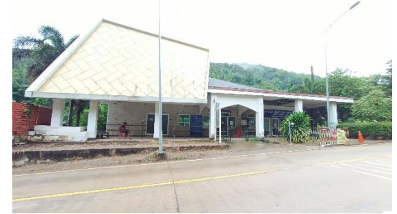
บริเวณอาคารสำนักงานด้านฯ กม.1+800 ซ้ายทาง
