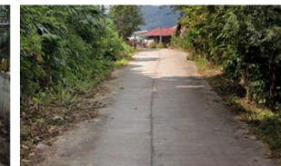
8 ถ.ท้องถื่น (ซอย 7)
