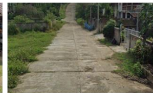
7 ถ.ท้องถื่น (ซอย 6)
